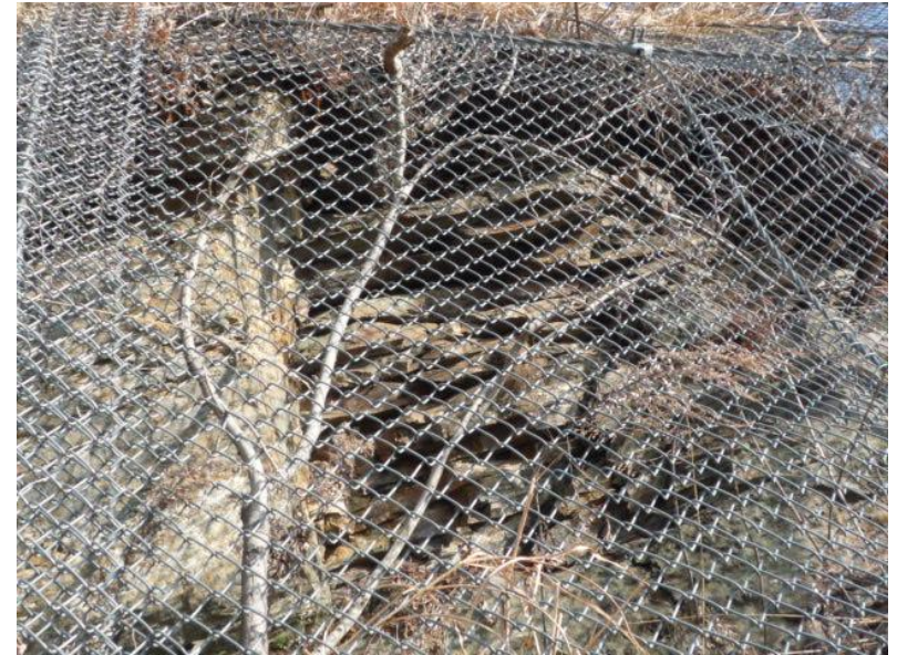
流れ盤構造となっている表土下の基盤
