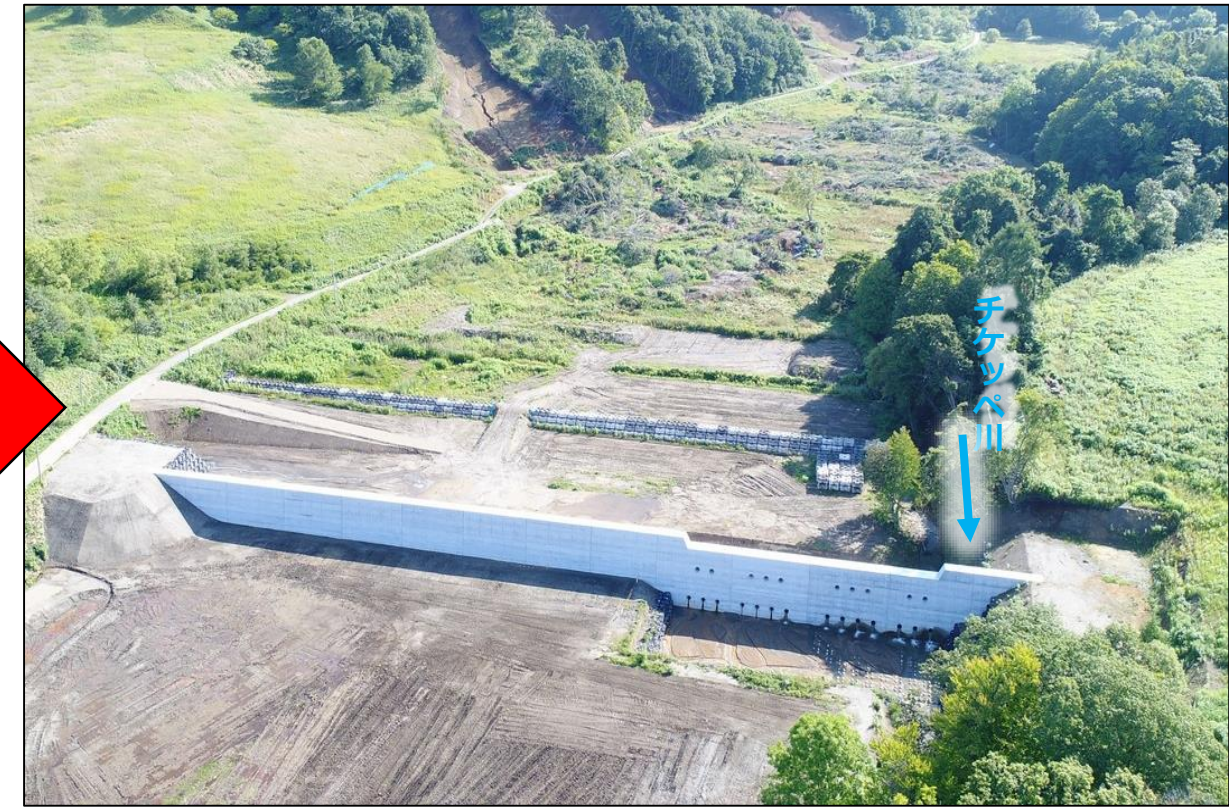
対策工事後 令和元年8月27日撮影
