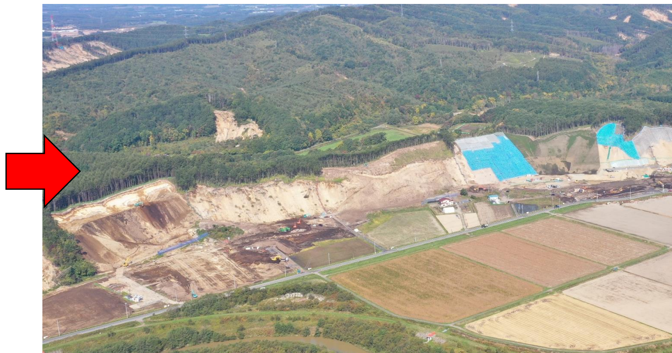
復旧工事 令和元年9月撮影
