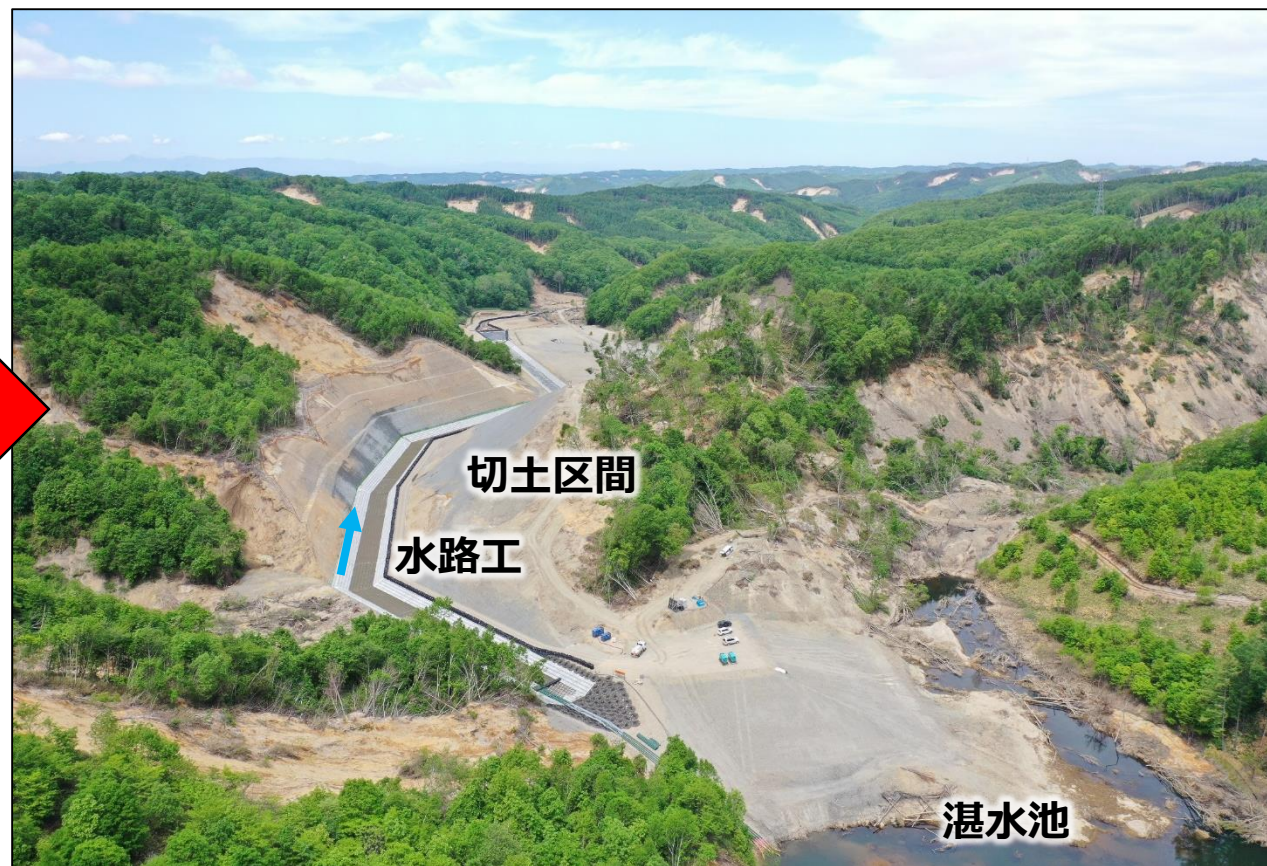
対策工事後 R元.5.29 撮影
