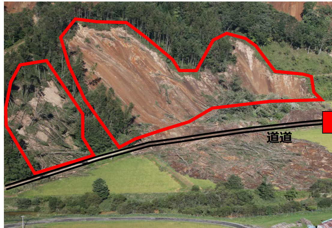
被災状況 平成30年9月撮影
