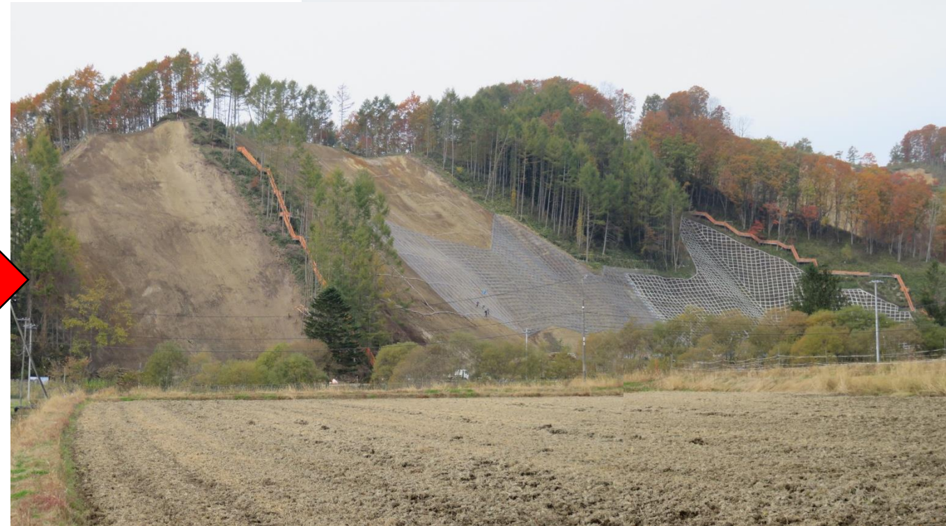
復旧工事 令和元年10月撮影
