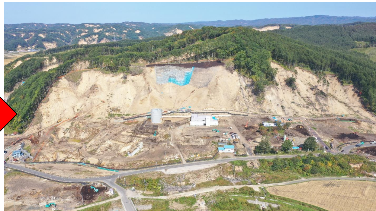
復旧工事 令和元年10月撮影
