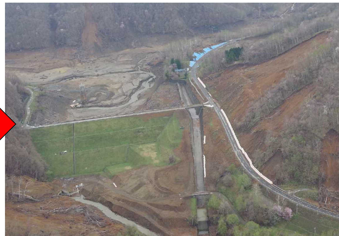
応急対策工事後 令和元年5月8日撮影
