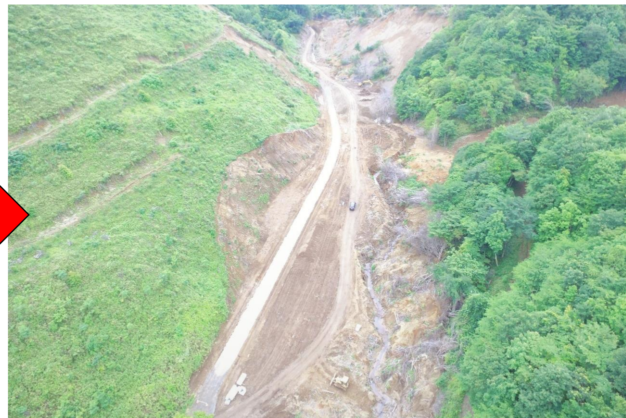
復旧工事 令和元年7月撮影
