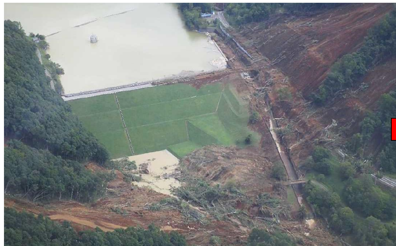
地震直後 平成30年9月7日撮影
