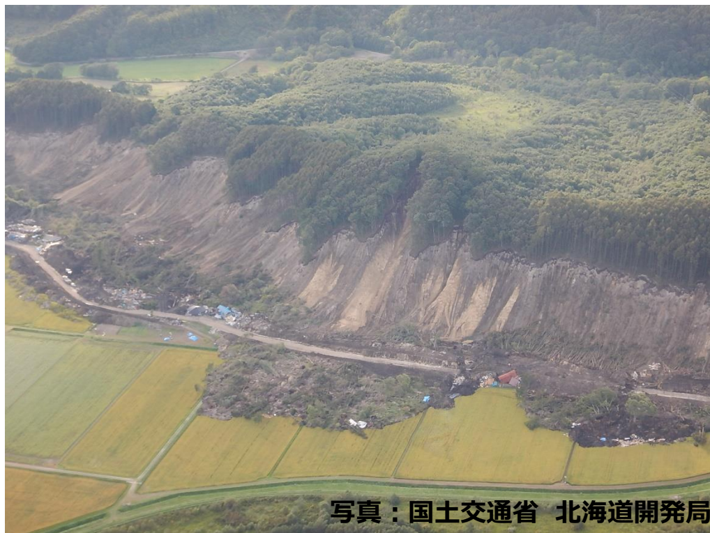
地震直後 平成30年9月22日撮影
