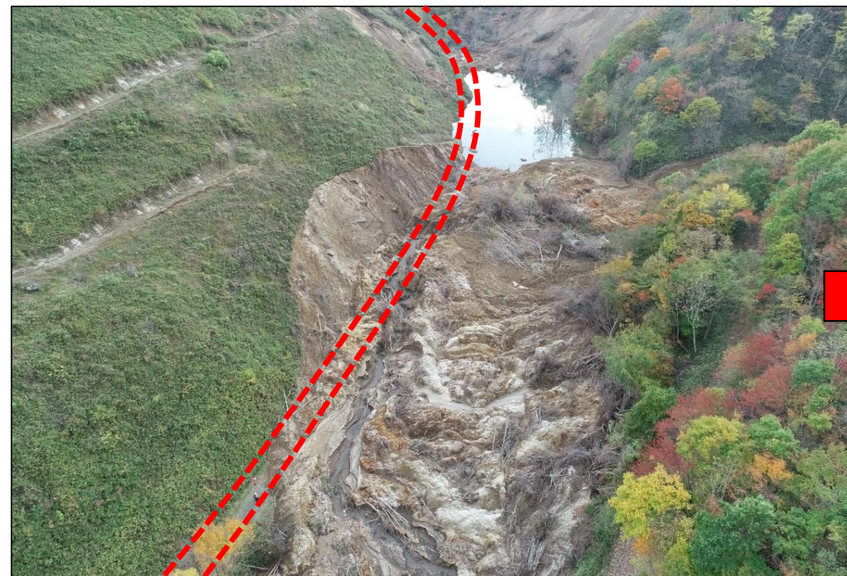
被災状況 平成30年9月撮影
