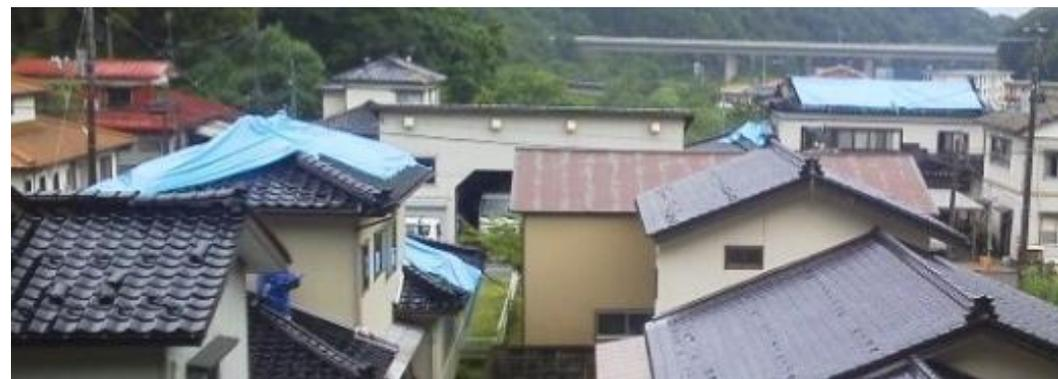
屋根瓦落下等(ブルーシートで養生)(鶴岡市)
