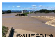
越辺川右岸0k付近
