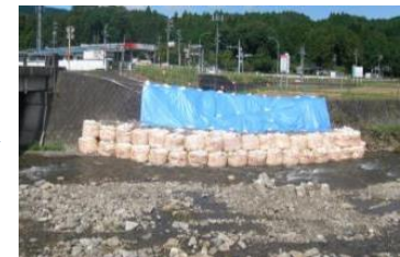
河岸の欠壊について、拡大防止のため に大型土のうで対策を実施
