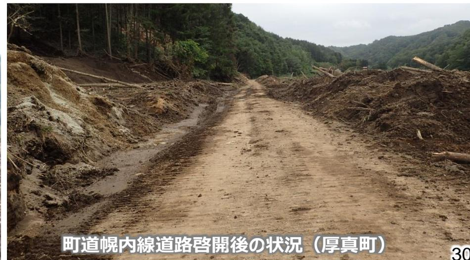
○災害発生直後から被害の拡大を防ぐため、建設業者と連携し、重機による流木や土砂の撤去など、過酷な災害現場の中で昼夜を問わず緊急復旧を実施。
