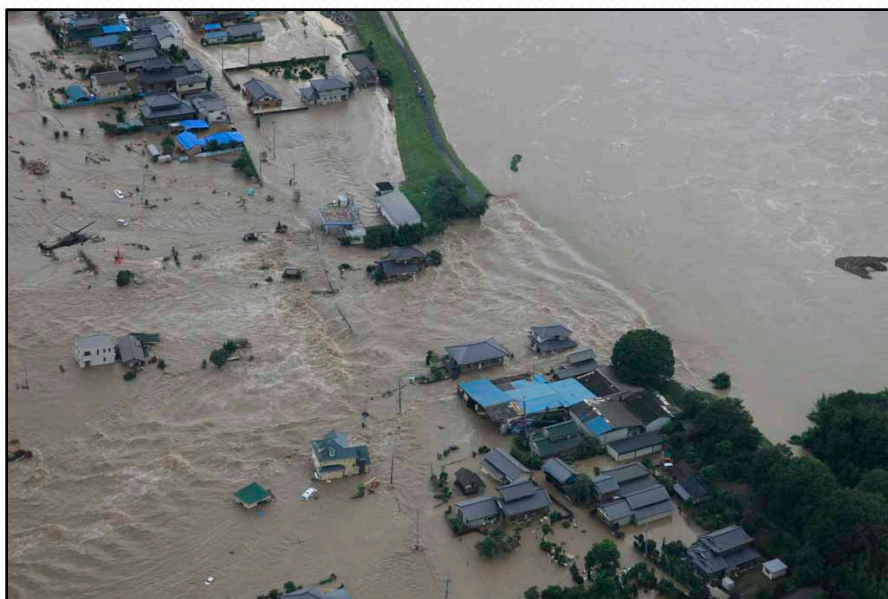
堤防決壊現場 (提供: 国土交通省関東地方整備局)
