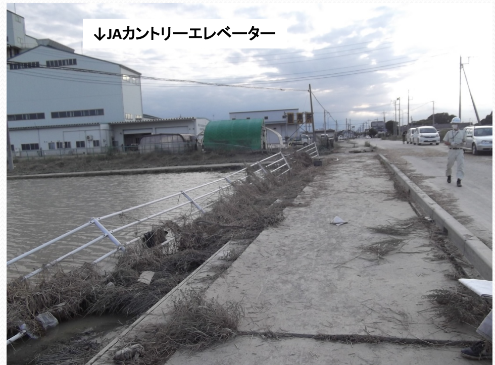
被災したJAカントリーエレベーター(常総市撮影)
