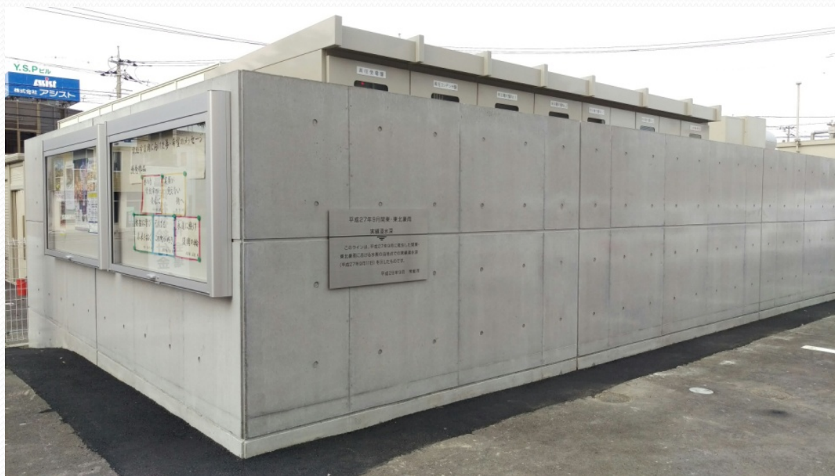
コンクリート壁で浸水対策を施した非常用発電設備
