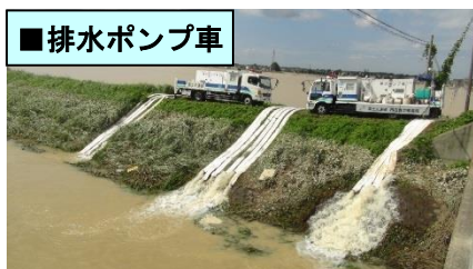
【 H27.9 関東・東北豪雨 】 (茨城県常総市)
