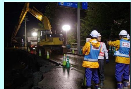
国道211号の道路啓開（東峰村）
