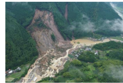
大規模な地すべりによる河道閉塞(小野川) 大分県日田市
