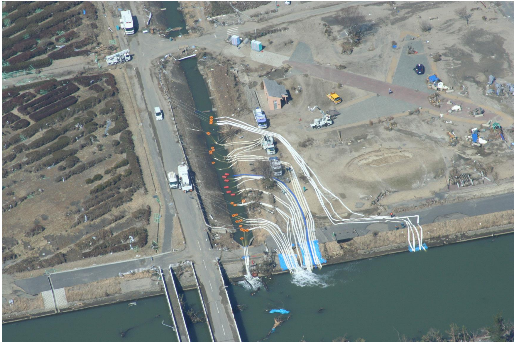
排水ポンプ車による緊急排水活動
