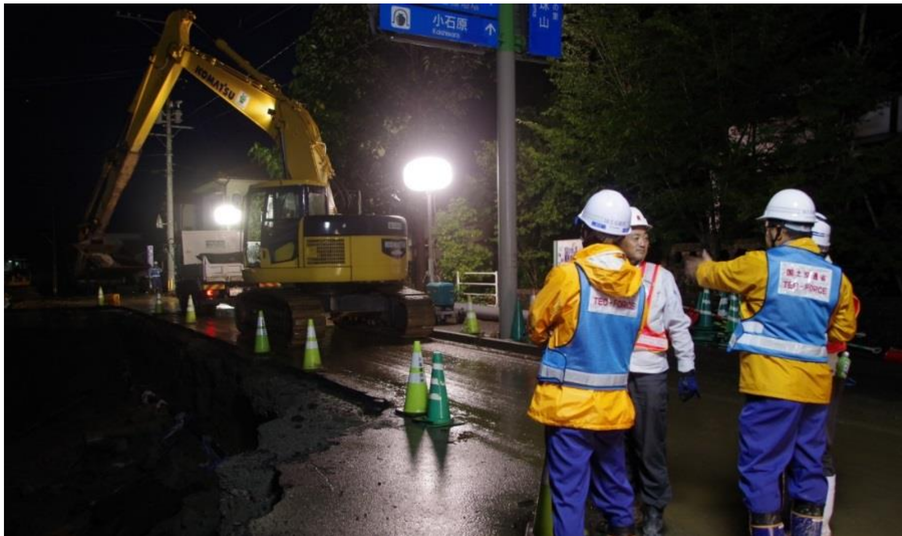
【国道211号(東峰村)の道路啓開状況】
