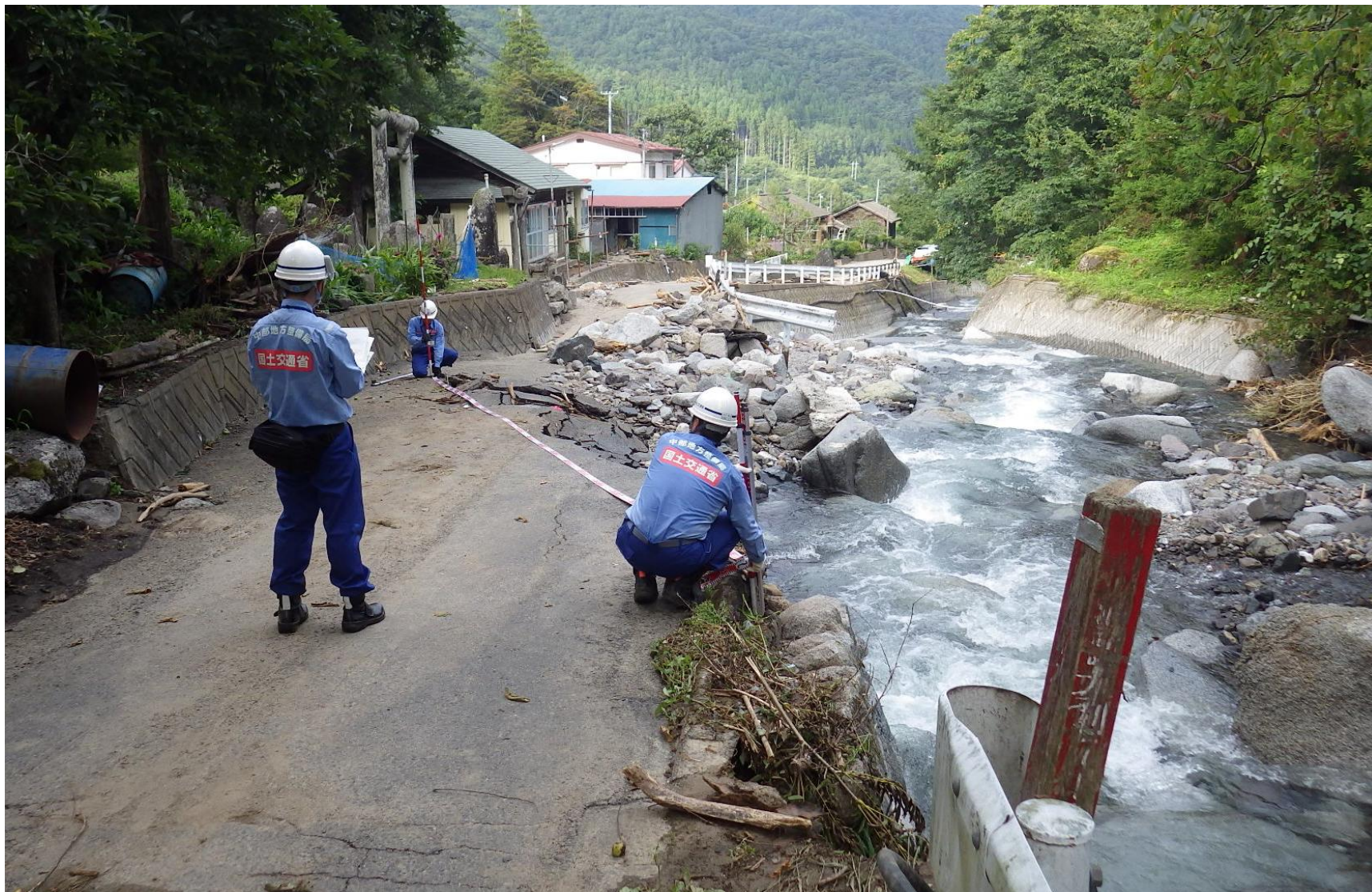
崩落した道路の状況を調査するTEC-FORCE
