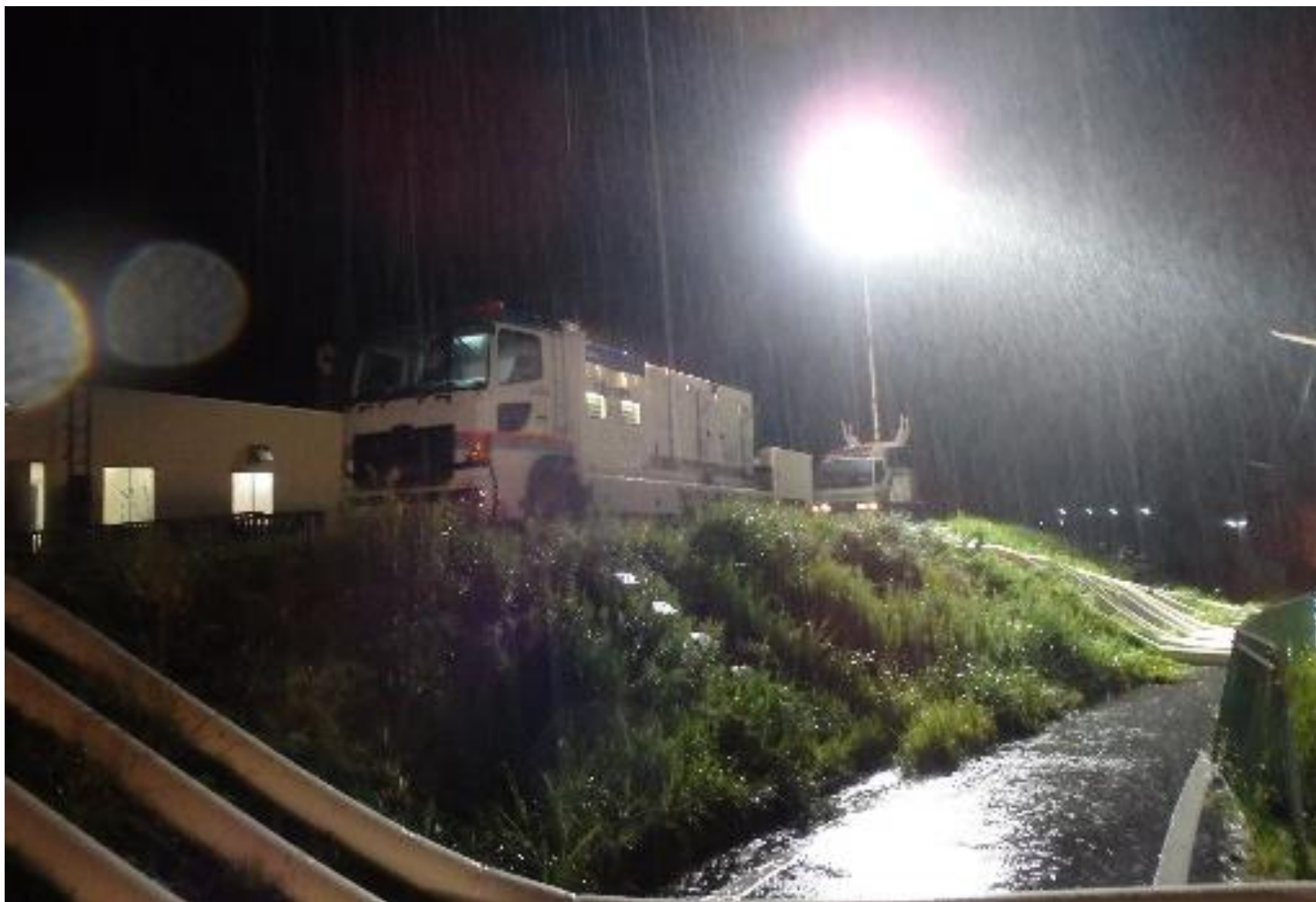
排水ポンプ車による緊急排水活動
