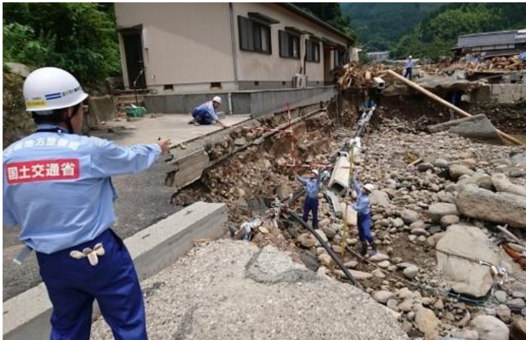
河川・道路の被害状況調査
