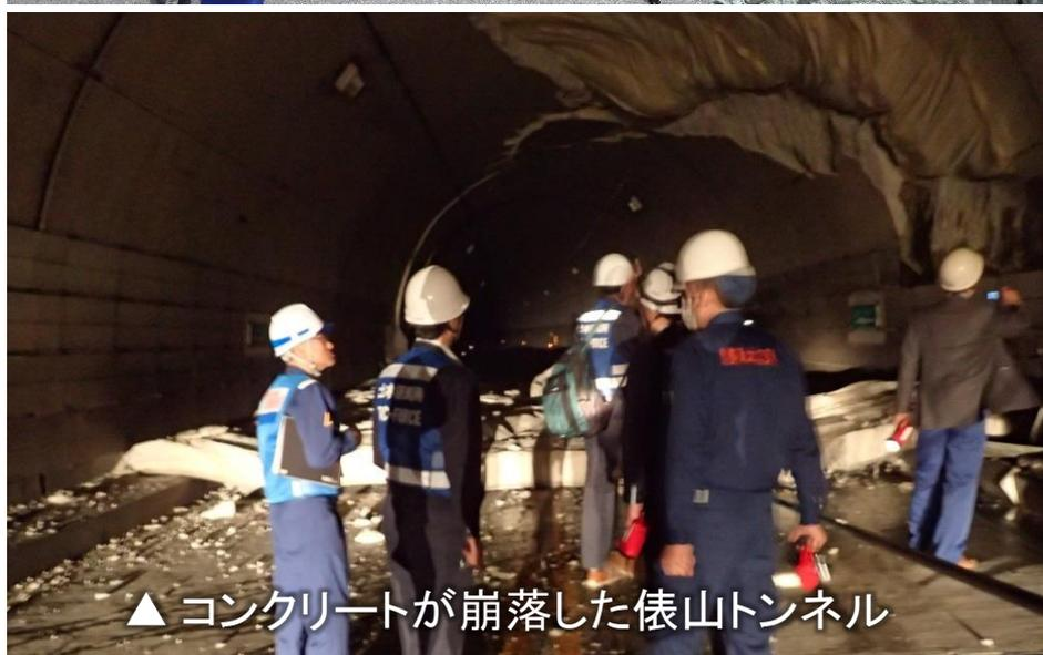
▲ コンクリートが崩落した俵山トンネル
