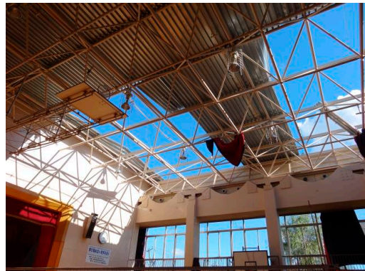
北陽中学校体育館における被災状況 (埼玉県)
