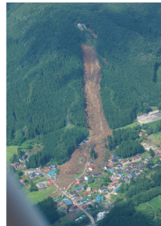
秋田県仙北市田沢湖田沢 供養佛 せんぼくしたざわこたざわ における土石流被害状況(秋田県)
