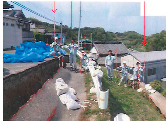
市道平田下道線における路肩欠壊状況(兵庫県)
