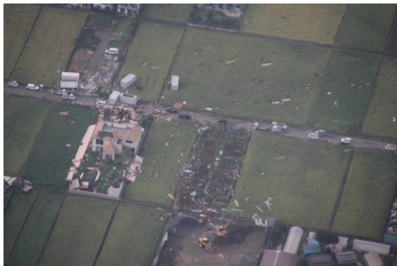
竜巻による家屋の損壊やコンテナの散乱 (埼玉県)
