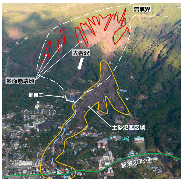
大島町元町における土石流被害状況 (東京都大島)
