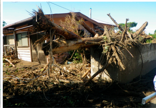
流木による家屋被害(東京都大島)
