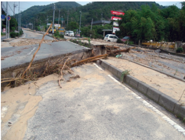
国道 262 号上勝坂橋 (山口県防府市)
