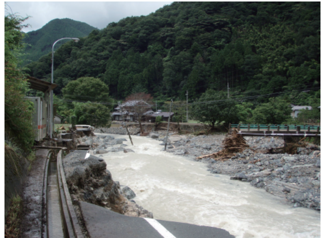
(主)一宮生野線 (兵庫県宍粟市)
