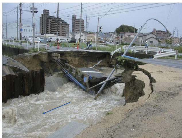
二級河川日長川及び国道155号東橋 (愛知県知多市)
