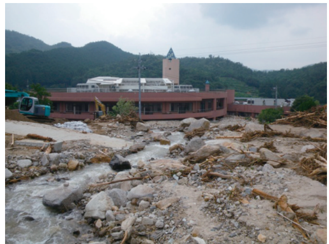
土石流による被災状況 (防府市真尾地区)
