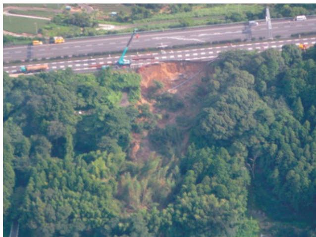
東名高速道路上り線 （静岡県牧ノ原市）
