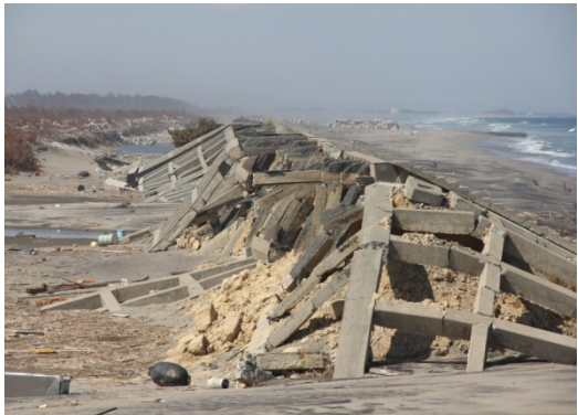
津波による海岸堤防の決壊・流出 二の倉海岸（宮城県岩沼市）
