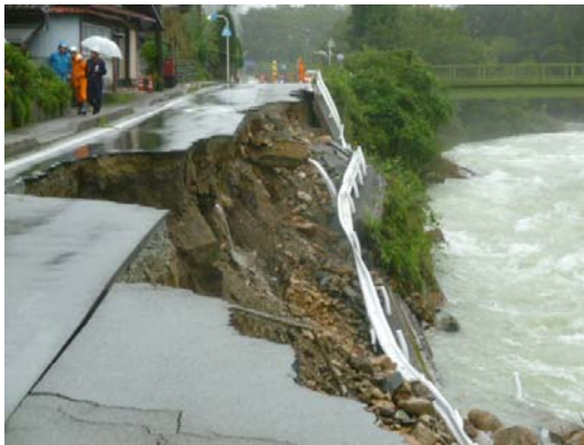
道路路面崩壊 一般県道湯屋温泉線 (岐阜県下呂市小坂町)
