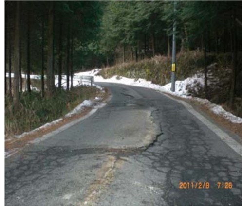
舗装面の亀甲状クラック及び盛り上がり、沈下（岐阜県）
