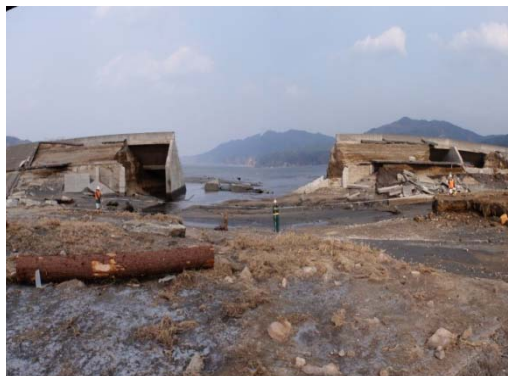
津波による海岸堤防の決壊・流出 金浜海岸（岩手県宮古市）
