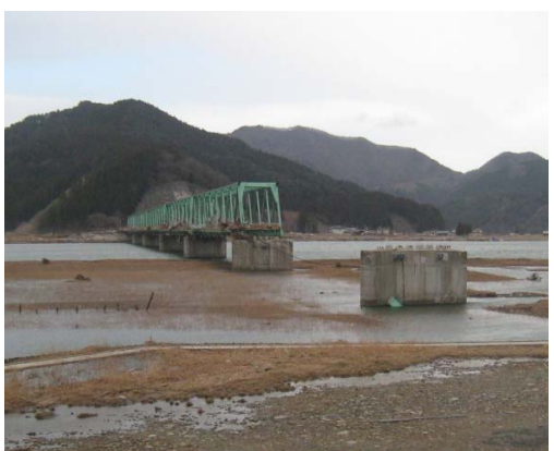
津波による橋梁の流出 新北上大橋（宮城県石巻市）
