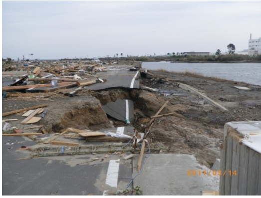
津波による河川堤防の決壊・流出 七北田川（左岸）河口付近（宮城県仙台市）
