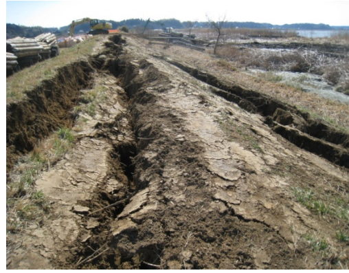
地震動による河川堤防の決壊 北印旛沼（千葉県成田市）
