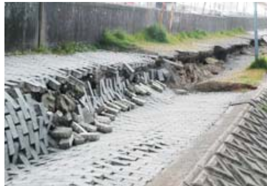
液状化により美浜境川沿いの崩れた歩道 (千葉県浦安市)
