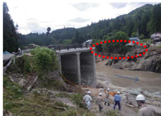
国道252号 二本木橋落橋 (福島県大沼郡金山町)
