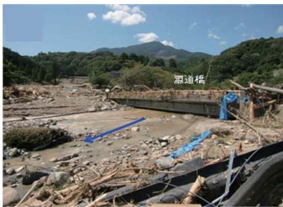
異常堆砂（和歌山県 那智勝浦町 井関地区）
