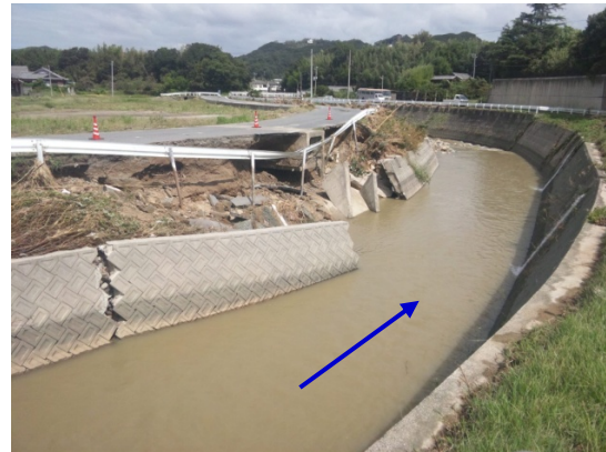
河川護岸の崩壊 岩戸川（兵庫県洲本市）
