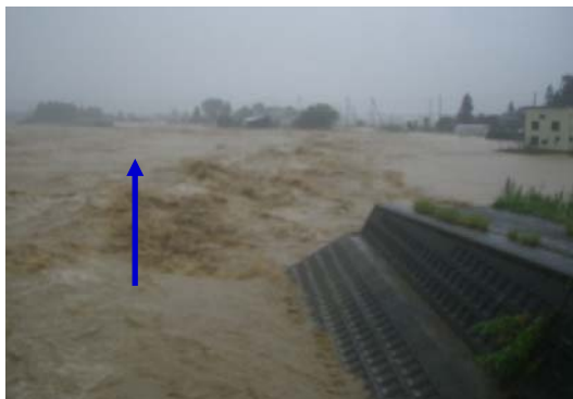
堤防の決壊 信濃川支川五十嵐川 (新潟県三条市江口地先)
