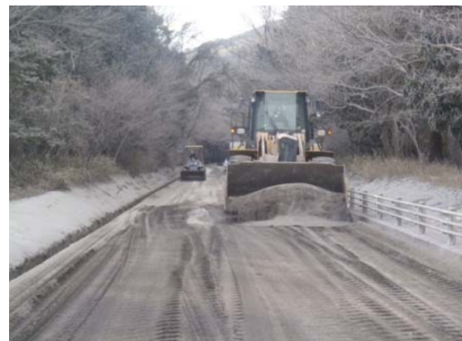
トラクタショベルによる降灰除去状況
