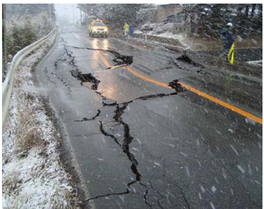
地震による路面の亀裂 一般国道342号（岩手県一関市）
