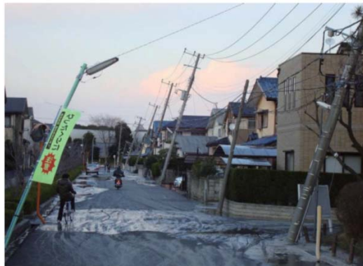
液状化により傾いた電柱 (千葉県習志野市)
