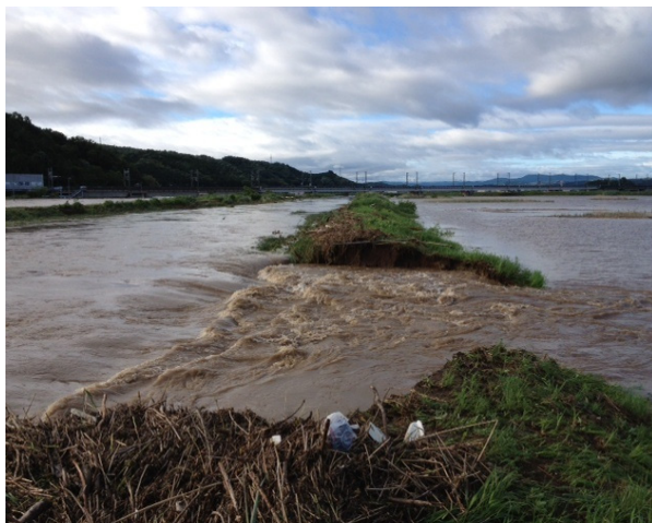
新川における破堤状況（宮城県）
