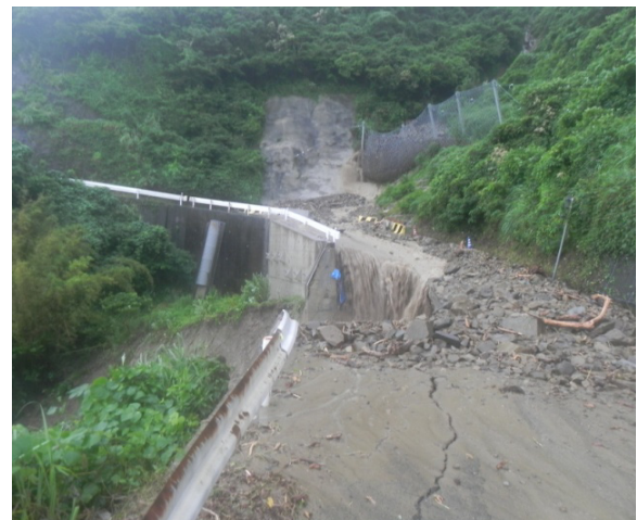
国道448号における路肩欠壊状況（宮崎県）
