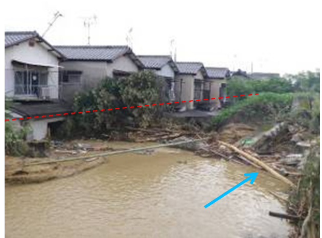
弥陀次郎川における破堤状況（京都府）
