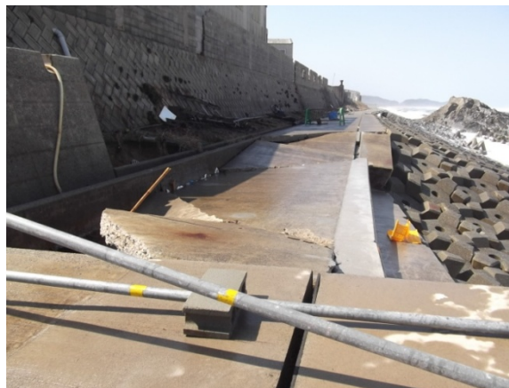
和木波子海岸における護岸の崩壊状況 (島根県江津市)
