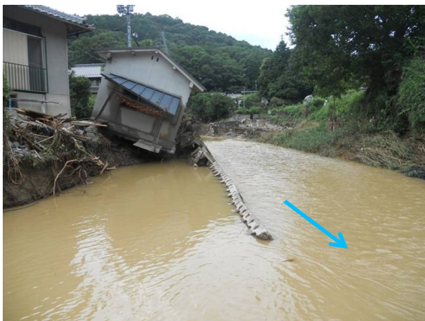
志津川における護岸崩壊状況（京都府）
