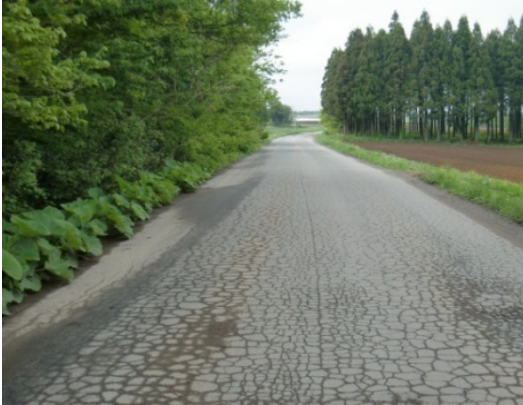
舗装面の亀甲状クラック及び盛り上がり、沈下（青森県東北町）
