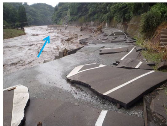
国道502号における路肩欠壊 （大分県）
