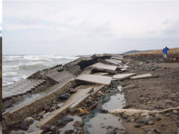
比子地区海岸における護岸の崩壊状況 (山形県遊佐町)
