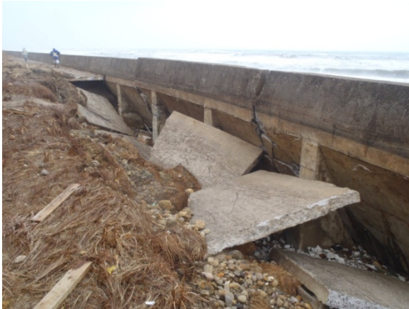
本荘海岸における護岸の崩壊状況 (秋田県由利本荘市)
