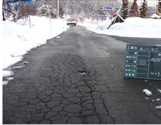
舗装面の亀甲状クラック及び盛り上がり、沈下（山形県東根市）
