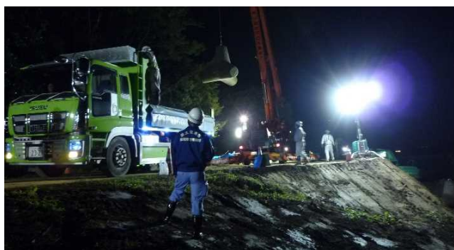
荒締切工の施工状況 (9月12日)
