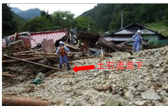
土石流出状況(滝向沢)
