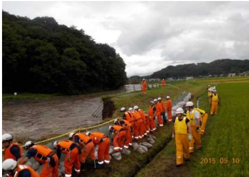
改良積み土のう工による漏水防止 栃木県宇都宮市 田川左岸(9月10日)
