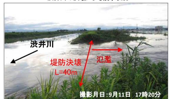
渋井川の決壊による浸水状況
