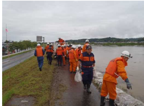
積み土のう工による越水防止 宮城県涌谷町 江合川左岸(9月11日)
