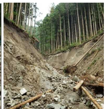
土石流出状況(中坪上沢)
