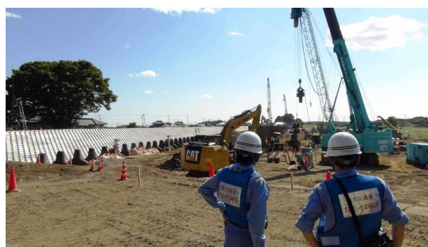
鋼矢板締切工の施行状況 (9月20日)
