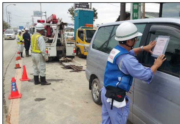
道路啓開による放置車両撤去（9月14日）
