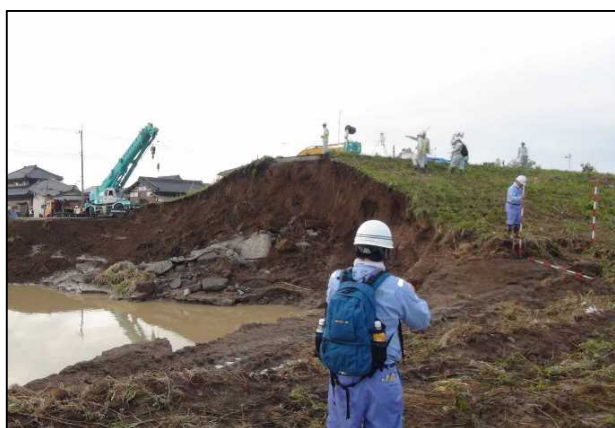
破堤地点における現地調査状況（9月12日）
