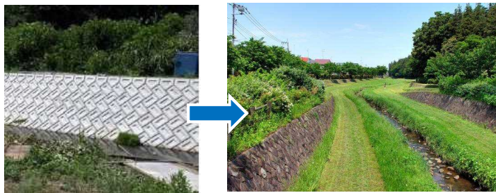
③コンクリート系の護岸利用時の景観配慮 (明度・彩度、テクスチャー等に配慮)
