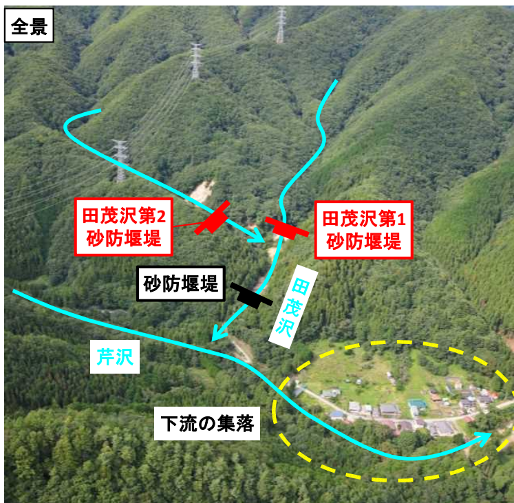
田茂沢第1砂防堰堤
