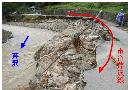
市道芹沢線の崩落状況
