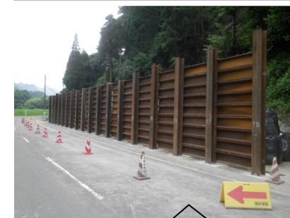
応急工事により仮設防護柵を設置済
