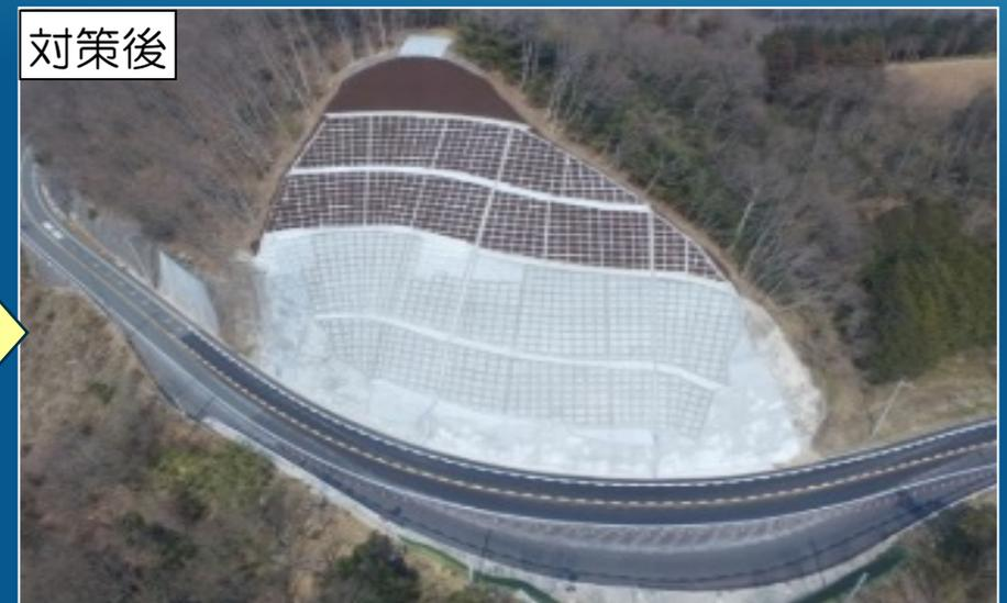
災害復旧事業の対象とならない風化・劣化による崖崩れで通行止めが発生したため、推進費により法面对策を実施。
