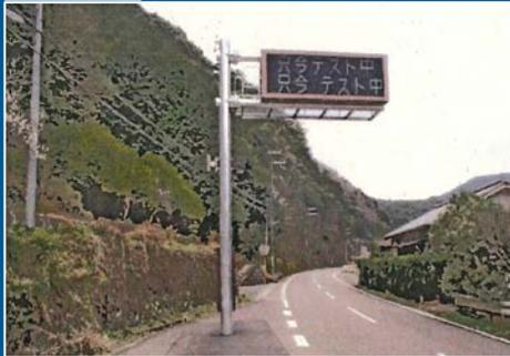
下りが連続する国道で速度超過により発生した死亡事故を受けて、危険箇所道路情報提供装置を設置。
