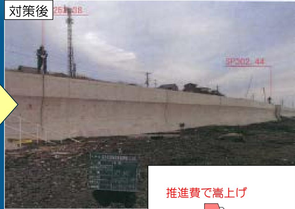
被災した護岸を災害復旧事業による原形復旧に合わせて、推進費により嵩上げを実施。
