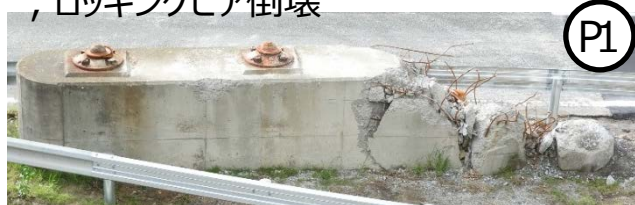
⑥【P1,P2橋脚】；ロッキングピア倒壊
