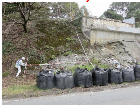
張ブロック：崩落
