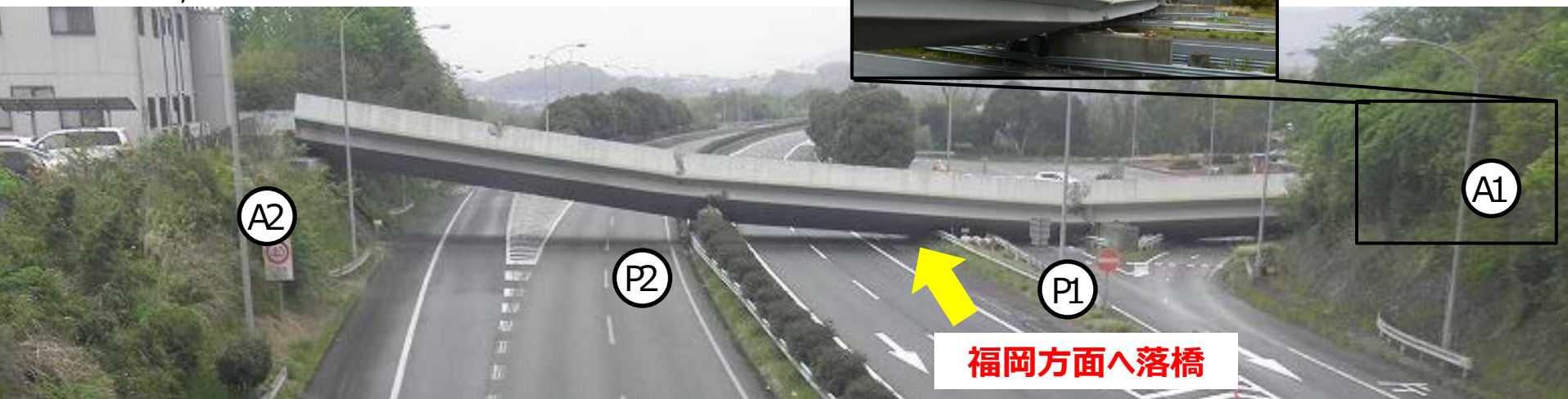
①【上部工】；落橋（全景）
