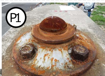
⑥【P1,P2橋脚】；ロッキングピア倒壊
