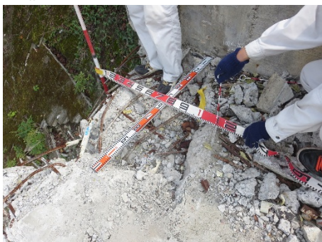
落橋防止構造：全壊
