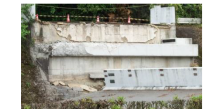
写真-2 横変位拘束構造の破壊、落橋 (県道小川嘉島線・府領第一橋)
