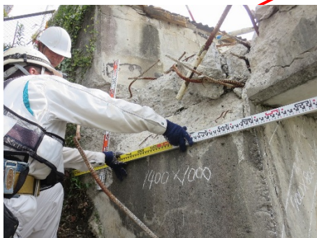
落橋防止構造：全壊
