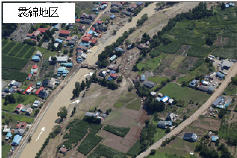
写真－1 小本川の被害状況
