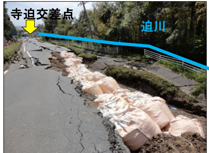
ゆすり込み沈下による路面崩壊(本震)
