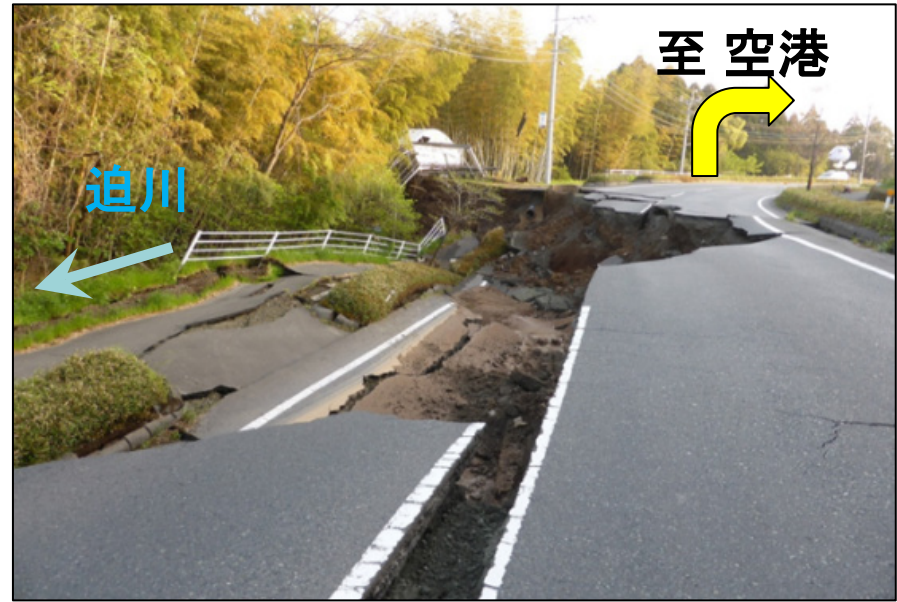
道路陥没箇所(前震後)
