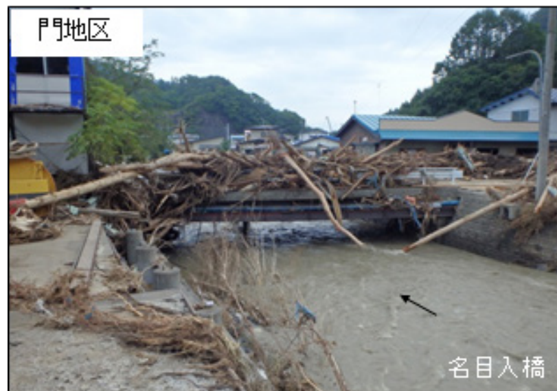
写真－3 流木による橋梁部への堆積状況
