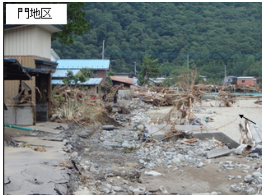
写真－2 護岸被災状況
