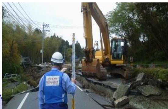
■ 国道443号(益城町)
