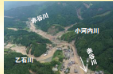
筑後川水系赤谷川における土砂・流木による堆積状況
