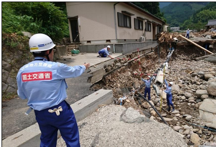
【県道52号(朝倉市)の被害状況調査(7/14)】
