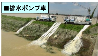
【 H27.9 関東・東北豪雨 】 (茨城県常総市)
