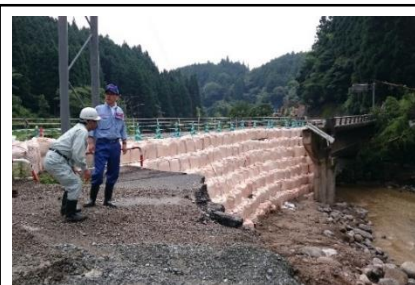
③大肥川の被災状況調査（東峰村） ※ 査定前着工（橋梁取付部の仮復旧及び復旧工法）を現地指導（7月12日）
