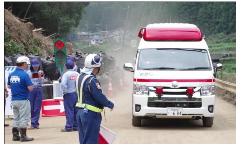
【道路啓開により緊急車両の通行を確保(7/14)】
