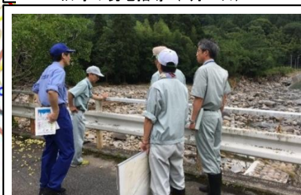
⑥山国川の被災状況調査（日田市） ※ 査定前着工（橋梁取付部の仮復旧及び復旧工法について現地指導（7月10日）
