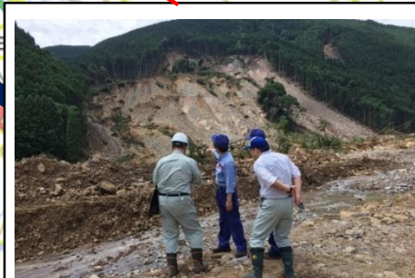
⑤小野川の被災状況調査（日田市） ※ 査定前着工（仮水路と取付道路の構造・平面位置）を現地指導（7月11日）
