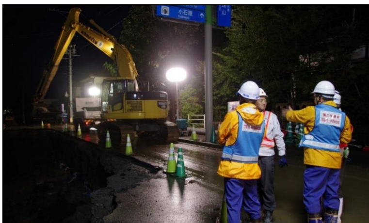
【国道211号(東峰村福井地区)の啓開作業状況(7/8)】
