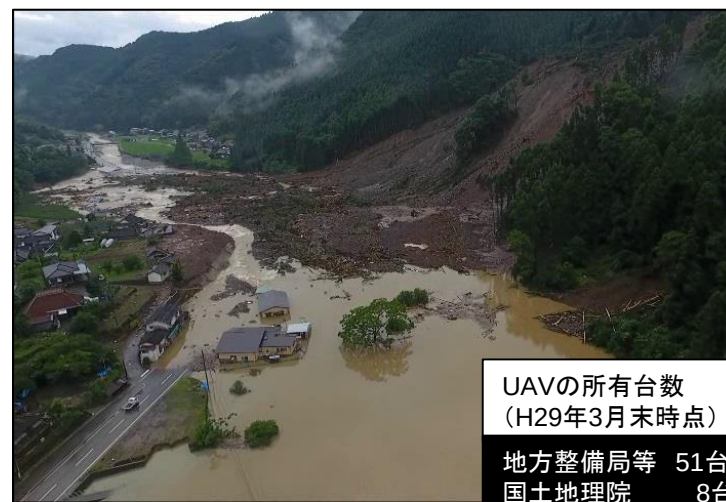
【小野川河道閉塞状況(7/7): 九州地整ドローン班】
