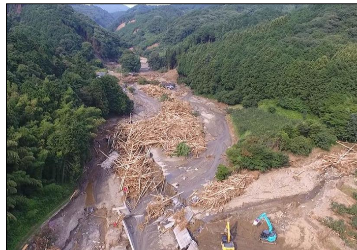
【奈良ヶ谷川流木堆積状況調査(7/13): 九州地整ドローン班】
