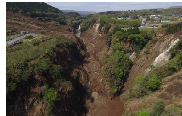
ドローンによる土砂崩壊箇所の被災状況調査 (南阿蘇村)
