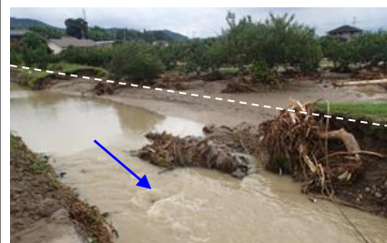
護岸の被災状況
