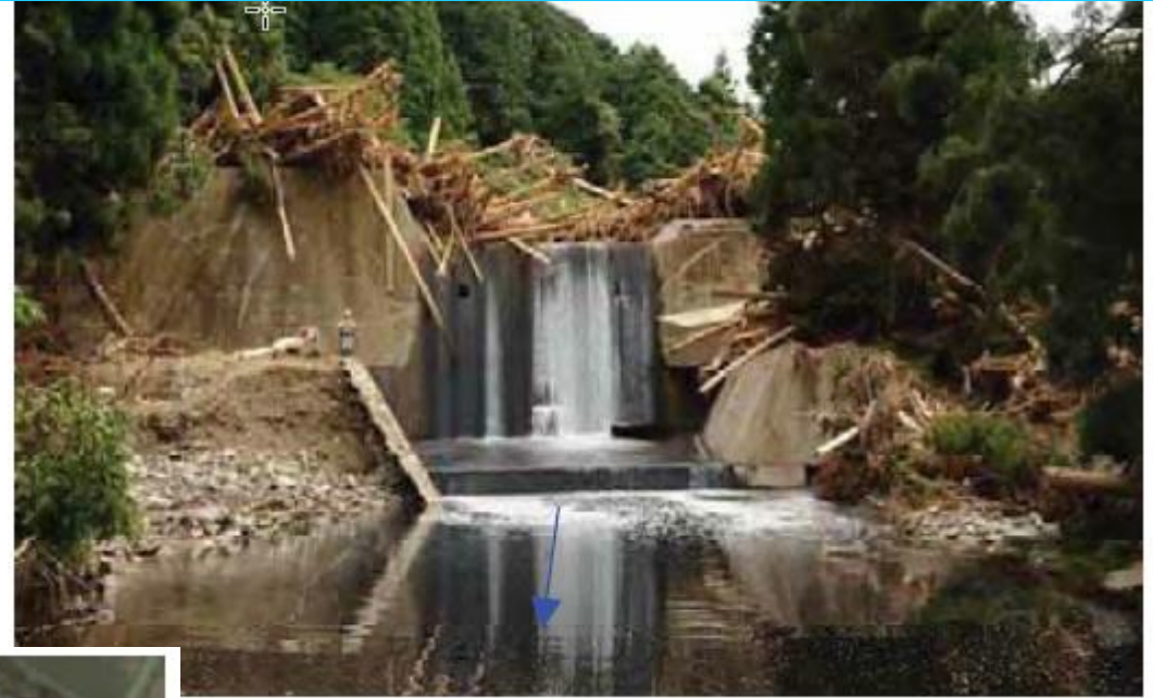
須川第一砂防堰堤下流から本堤を撮影
