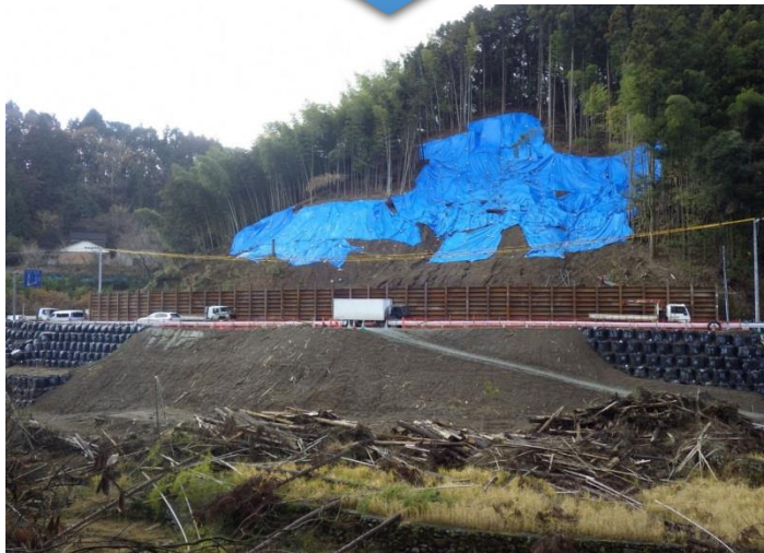
(国道211号・東峰村福井)
