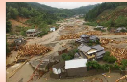
大量の土砂で埋没した赤谷川
