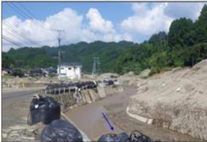
応急復旧（継続）
