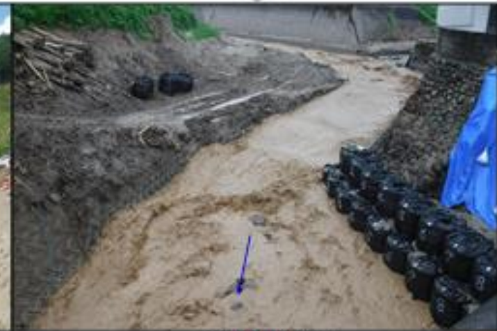
応急復旧（継続）
