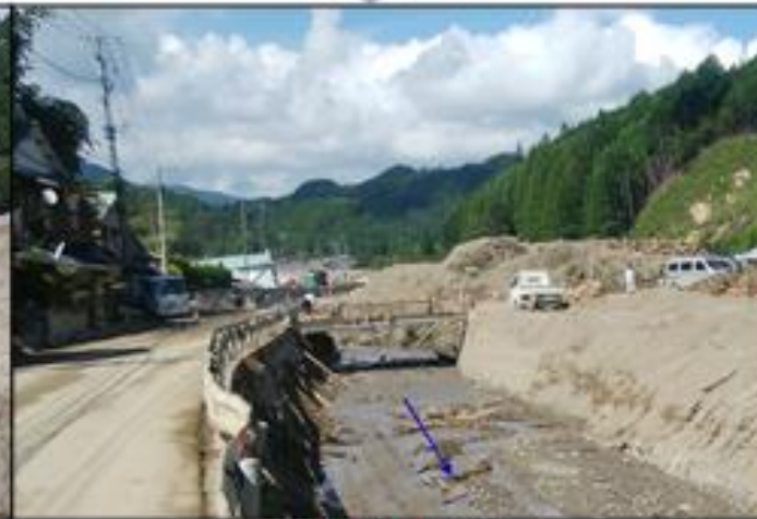
応急復旧（継続）
