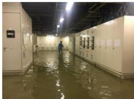
地下電源設備の浸水被害
