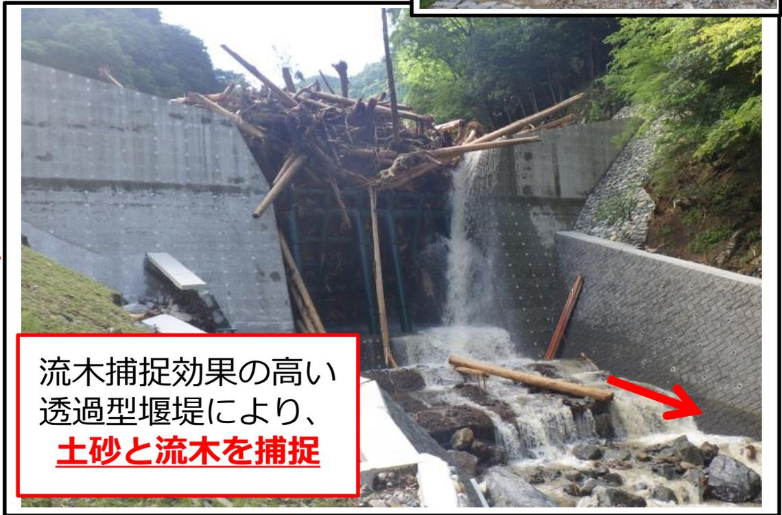
流木捕捉効果の高い透過型堰堤により、
