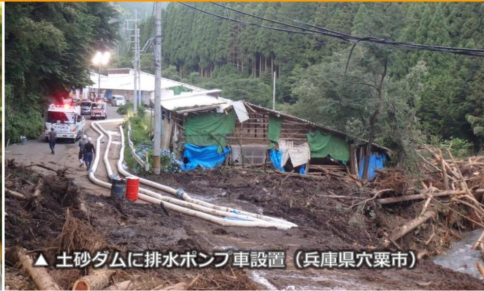
▲土砂ダムに排水ポンプ車設置(兵庫県穴栗市)
