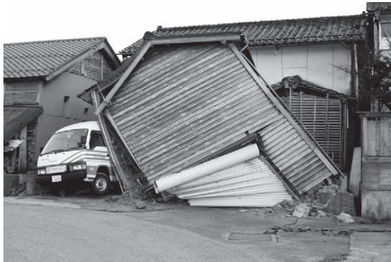
倒壊家屋①
