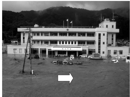
建物裏を流れる足羽川が氾濫し、1階が水没した旧美山町庁舎（福井市美山町）
