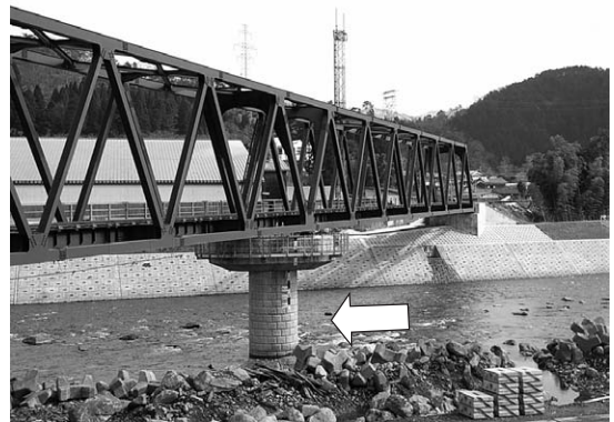
改良工 河積拡大、橋梁架替
