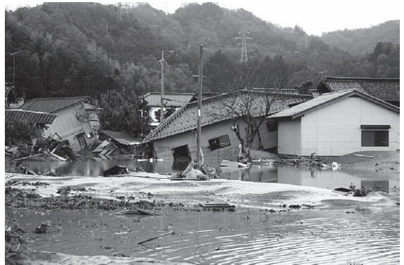
堤防決壊により水流に押しつぶされた家屋
