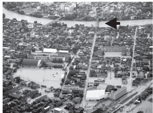
三条市街地 浸水状況 (H16.7.14)
