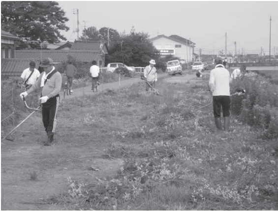
市民による堤防の草刈りの状況（H19.7月）
