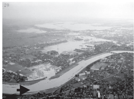
諏訪地区(左岸) 破堤状況 (H16.7.14)
