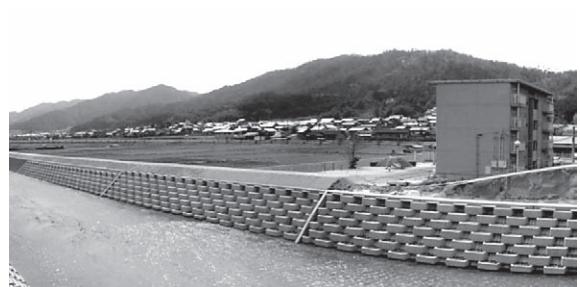
復旧後（野田川堤防）
