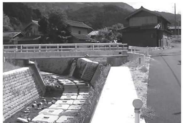
復旧後（野田川上流部）
