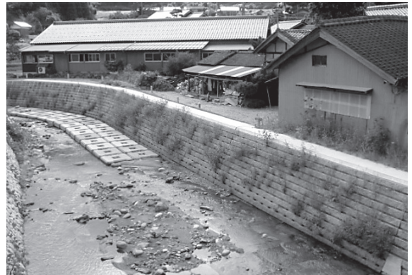
復旧後（野田川上流部）
