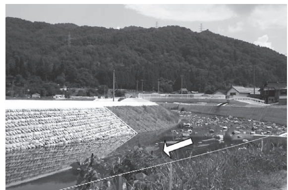
出原川改良復旧後
