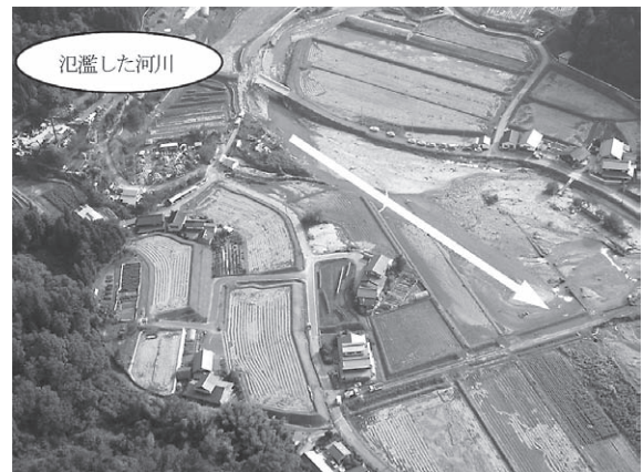
出原川被災航空写真（撮影：広島県）
