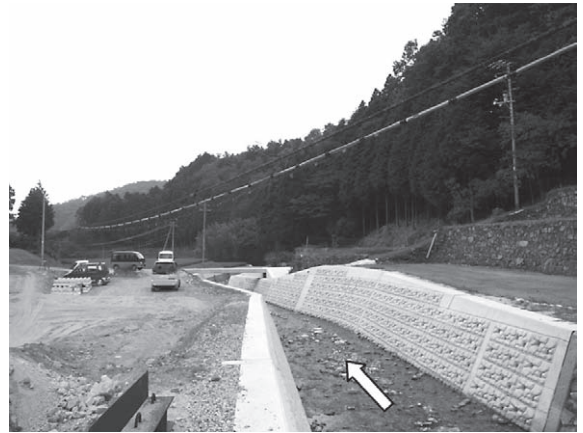
根の谷川改良復旧後
