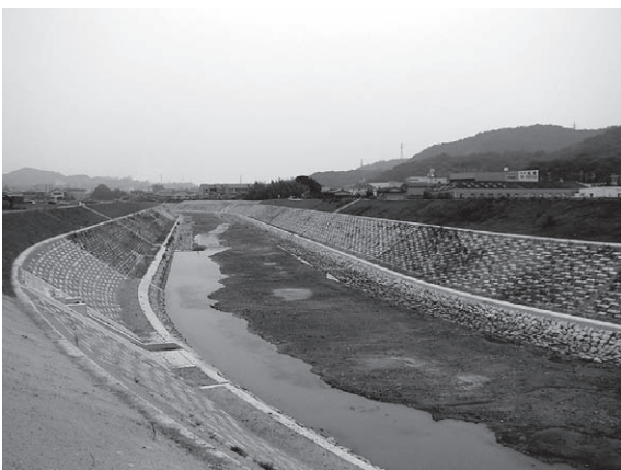
写真-17 完成した新しい護岸（洲本川：加茂地区）
