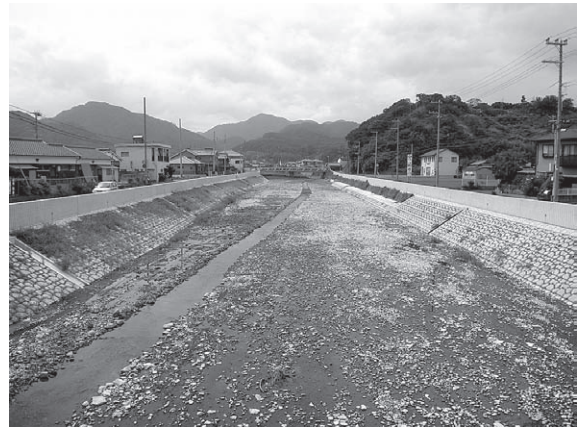
写真-18 完成した新しい護岸 (千草川：諏訪橋～野旦田橋)
