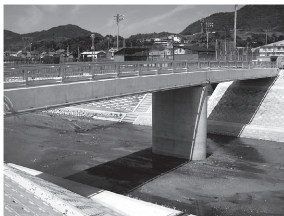
写真-14 激甚災害対策事業第1号の完成（洲本川：大森谷橋）
