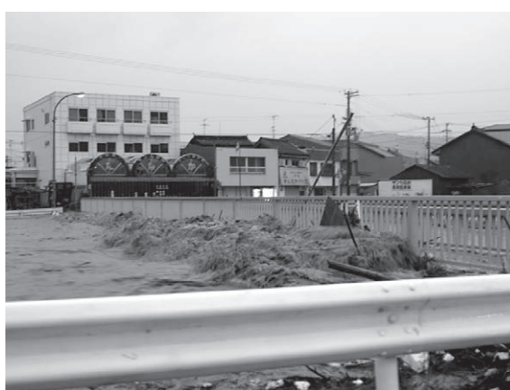
写真-6 水が橋上にあふれ出した物部橋
