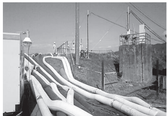
冠水箇所の排水作業
