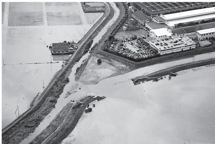
広田川破堤箇所
