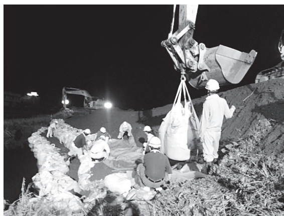
仮締め切工事（夜間作業の様子）
