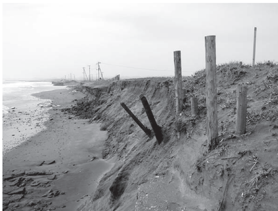
被災状況写真
