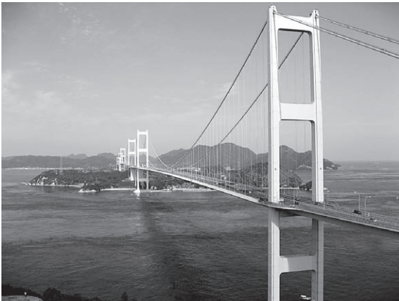
写真－1 世界初の三連吊橋来島海峡大橋
