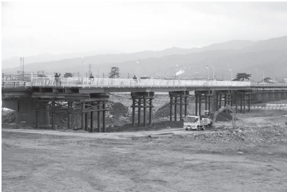
写真－8 仮橋が完成
