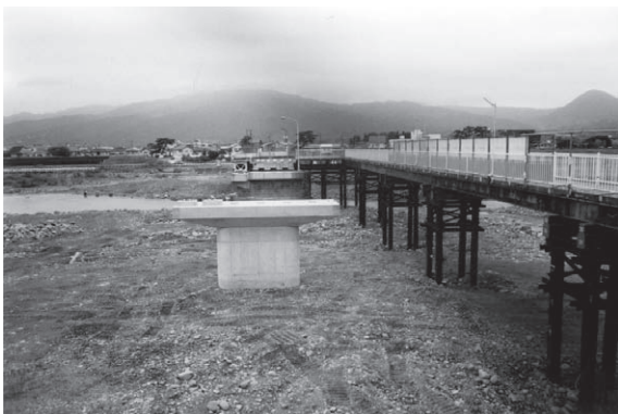
写真－9 橋脚が完成
