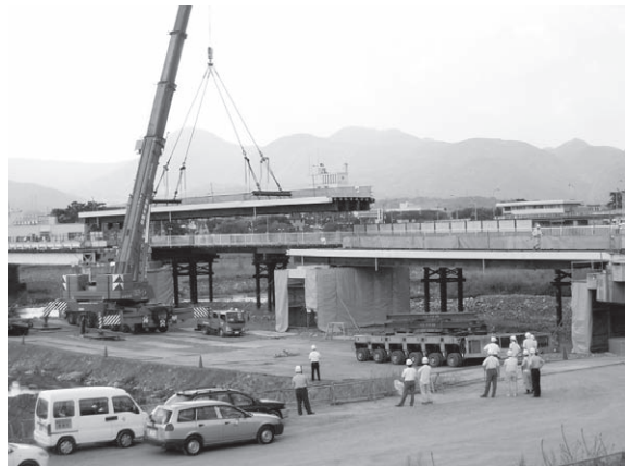
写真－10 橋桁の架設
