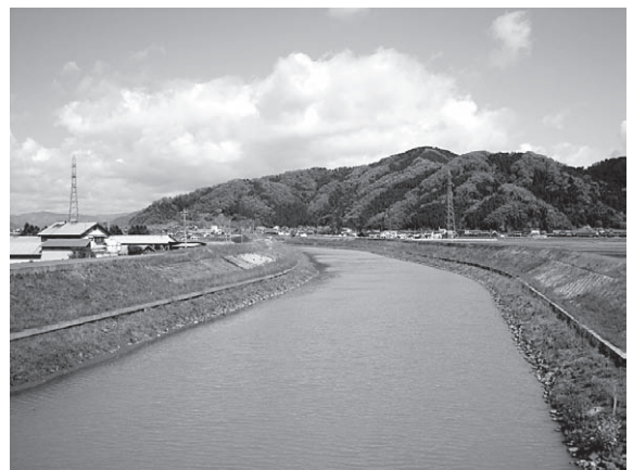
改修後（水窪橋 下流）
