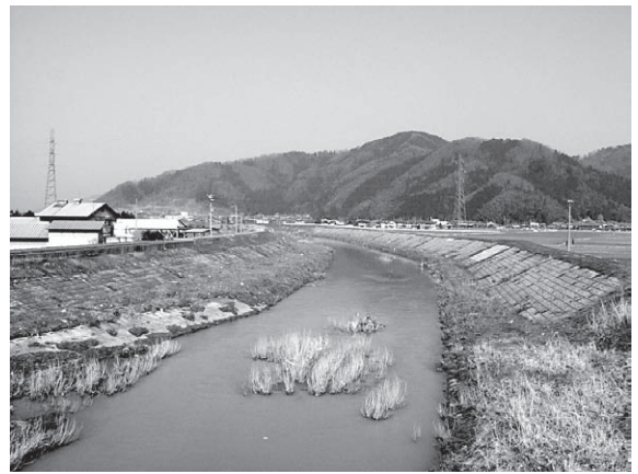
改修前（水窪橋 下流）
