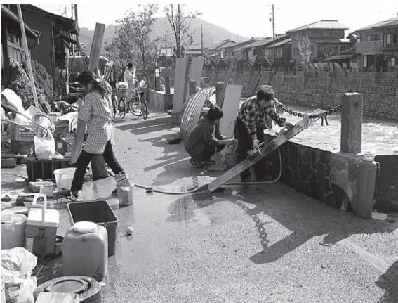
写真-4 住宅の復旧状況 (古川町地内)
