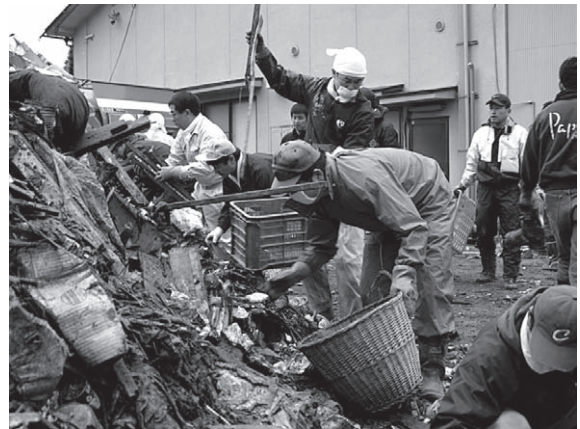
写真-6 ボランティアによる復旧状況(ゴミの処分)
