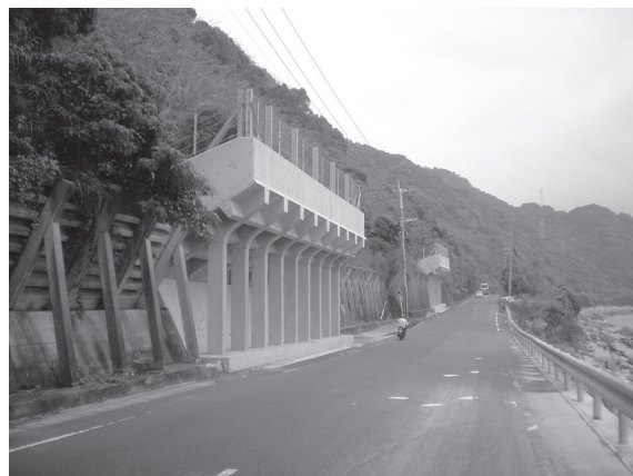
写真－5 写真－1部復旧状況
