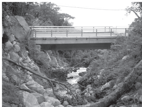
写真－6 写真－2部復旧状況
