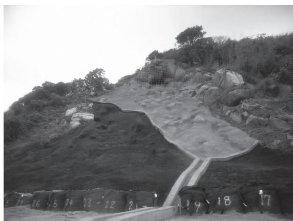
写真-8 写真-7 部復旧状況
