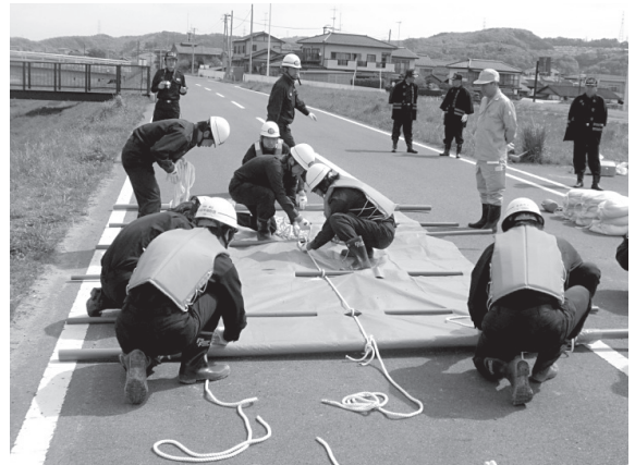
シート張り工法
