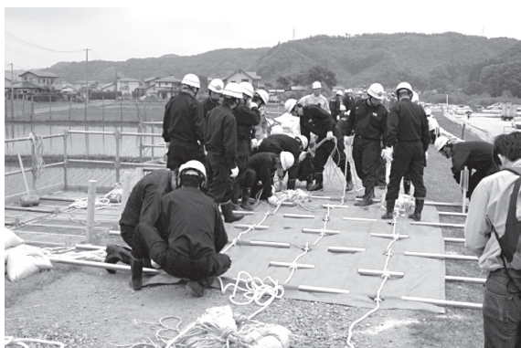
シート張り工
