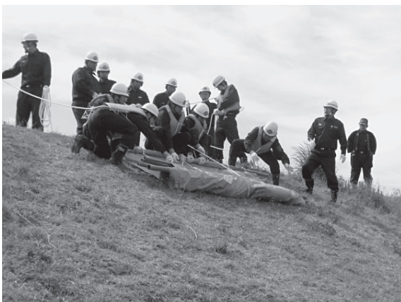
シート張り工法
