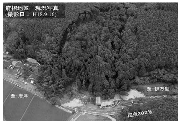
写真-5 一般国道202号地すべり状況
