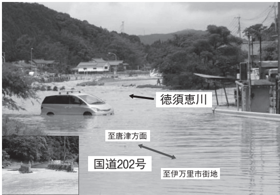
写真-6 越水状況
