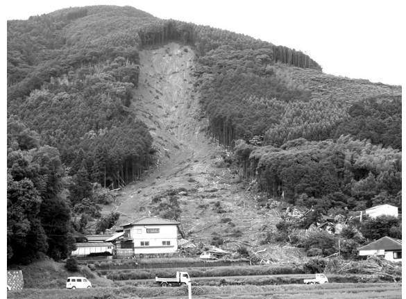
上弁城地区土砂崩れ
