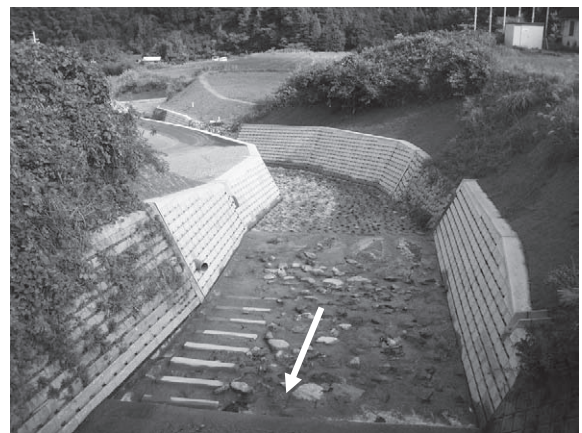
写真-3 完成写真
