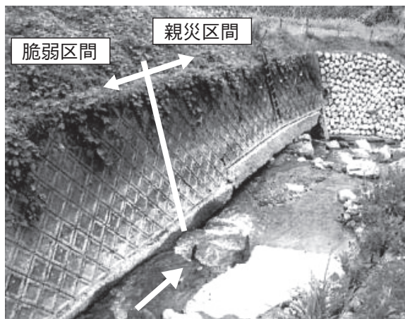
写真-2 脆弱な未被災護岸
