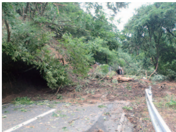
7月15日豪雨 国道482号（岡山県真庭市）
