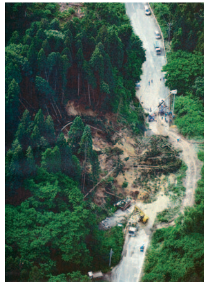
写真－9 土砂崩落による道路埋塞（大蔵村）
