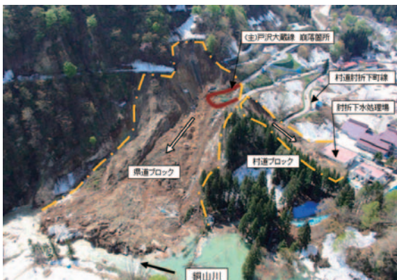
写真-1 地すべり全景写真
