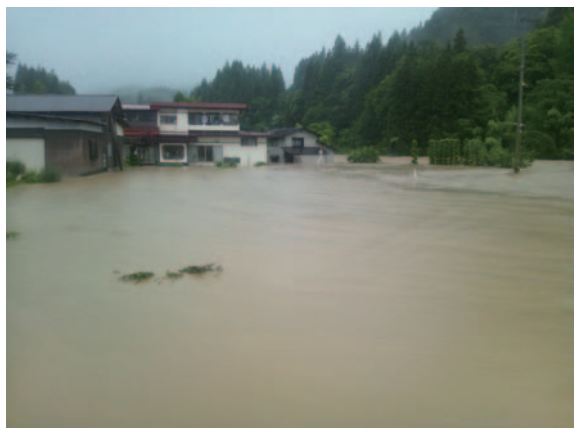
写真-14 出水状況（大江町）
