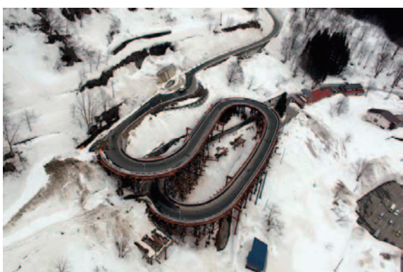
写真－4 仮栈橋での供用（H24.12.31）
