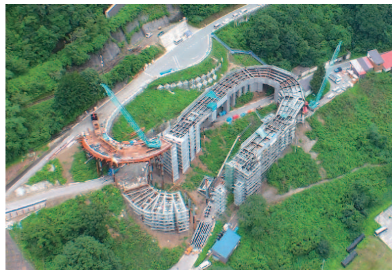
写真－5 上部工桁架設状況
