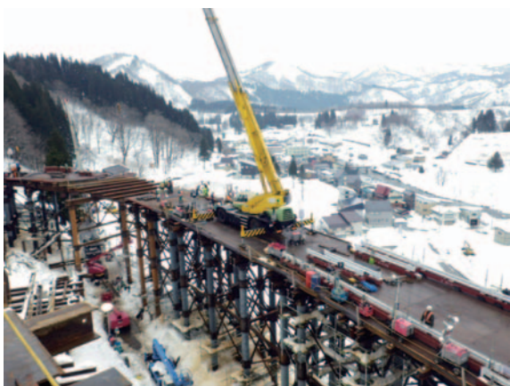
写真－3 橋桁・覆工板の設置
