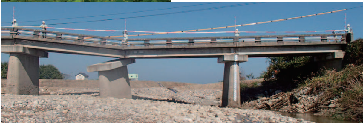
主要地方道立山山田線高善寺橋（富山市八尾町）
