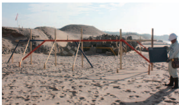
写真-3 丁張り設置状況
