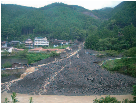
辻堂地区（鍛冶屋谷）の被災状況
