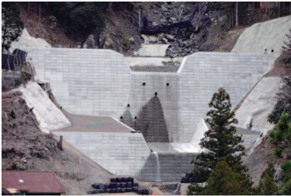
辻堂地区（鍛冶屋谷）復旧状況
