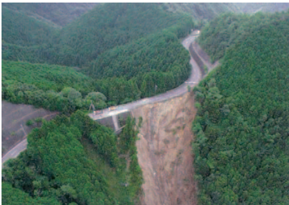
写真－1 23年災 県道田辺龍神線の被災状況（延長約100mに渡って崩落し全面通行止となった）
