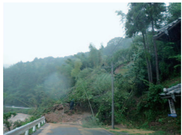
写真－3 25年災 国道370号の被災状況（法面崩壊により土砂が道路を塞いだ）
