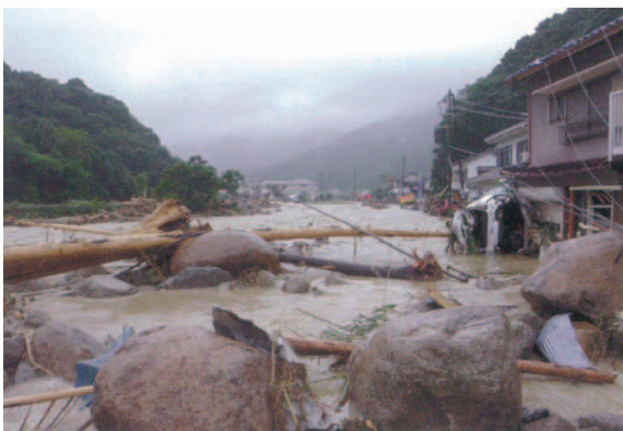
写真－2 23年災 那智川のはん濫後の状況（土石流により河道閉塞が発生し甚大な被害となった）
