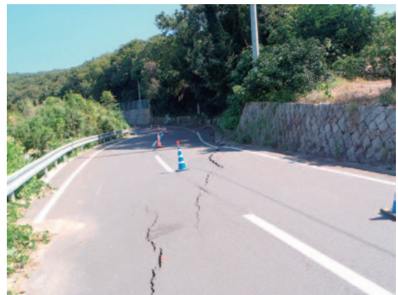
全景（終点側より撮影）
