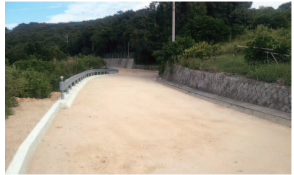
復旧完了写真（舗装工事前）終点側より
