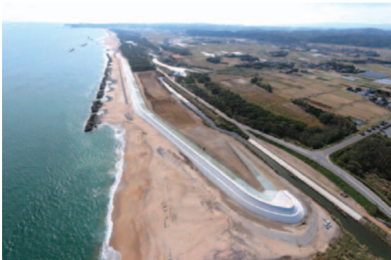
写真-6 完成した夏井地区海岸堤防
