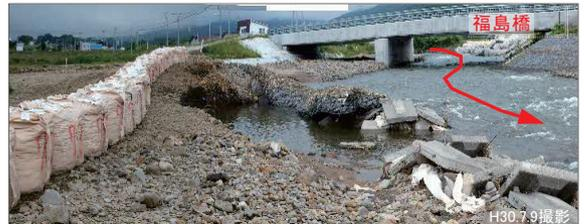
写真-2 福島橋下流 護岸の被災状況
