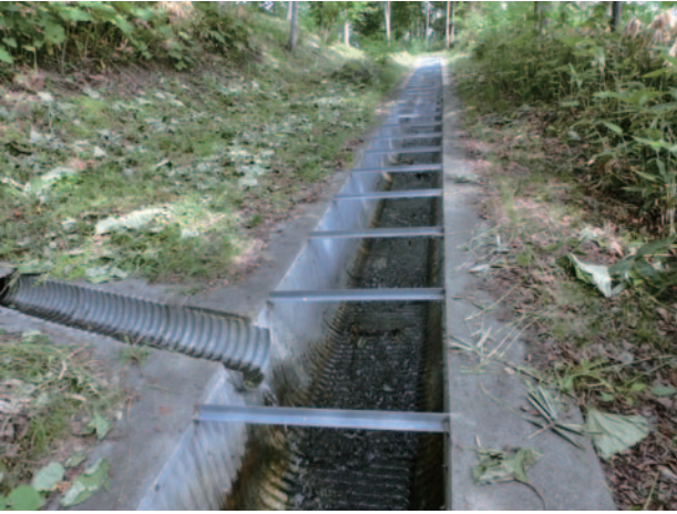
新設水路 (写真③)
