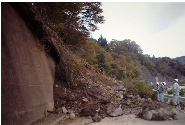
写真－7 木村地籍の土砂崩落状況
