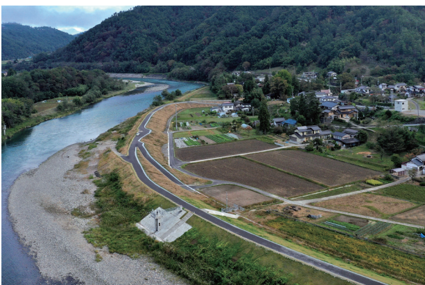
写真-12 竣工した小立野区の堤防
