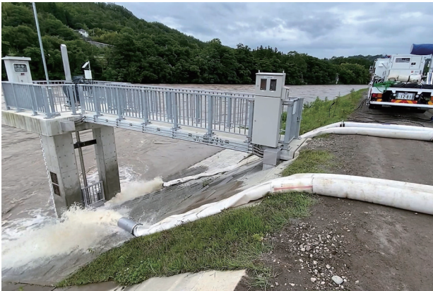
写真-19 排水ポンプ車の排水作業の様相
