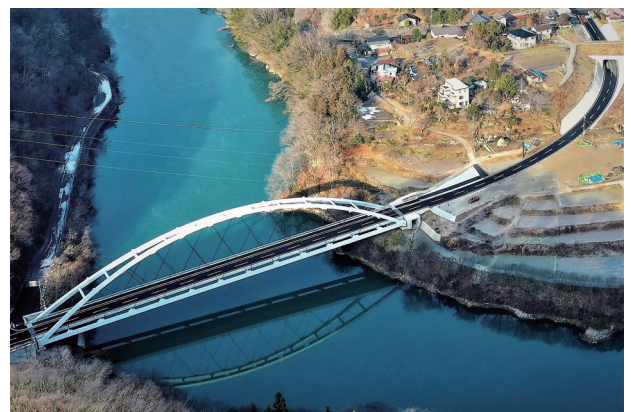
写真-13 開通した山清路バイパス(山清路大橋)
