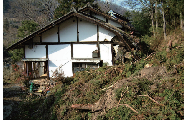
写真－8 宇留賀区の家屋崩壊状況
